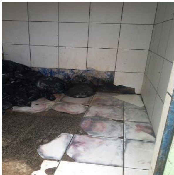
Foto 01 – Abrigo de resíduos de saúde, lixo comum.
