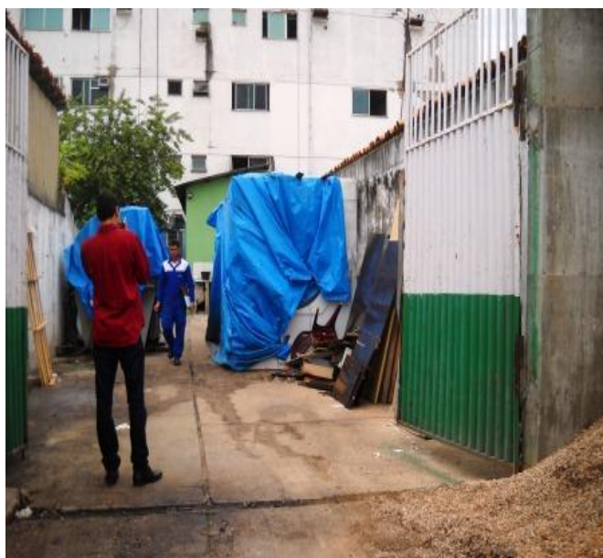
Foto 01 - Máquinas obstruindo o acesso lateral do HMI.
