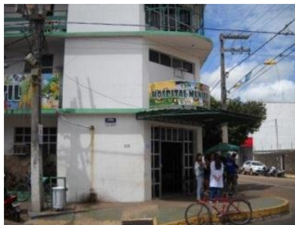
Foto 02- Fachada do HMI – Unidade pediátrica.
