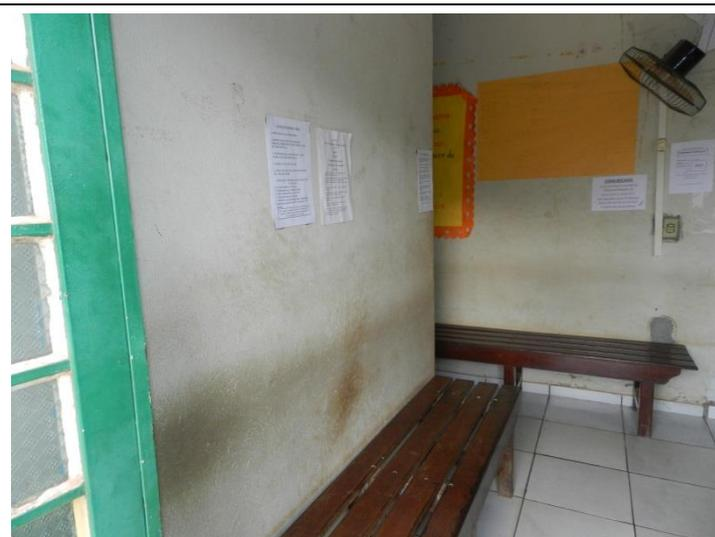
Foto 26 - Paredes com pintura deteriorada e marcas de sujidade – USF Centro Novo.
