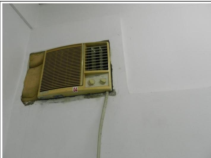
Foto 38 – Inexistência de moldura em equipamento de ar-condicionado – C. S. Dr. Milton Lopes.
