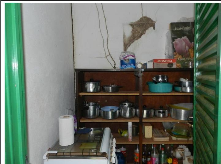
Foto 23 – Paredes da despensa com marcas de cupim – USF Coquelândia.
