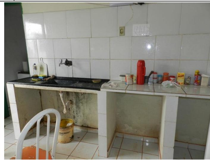
Foto 22 – Paredes da cozinha com infiltração – USF Coquelândia.
