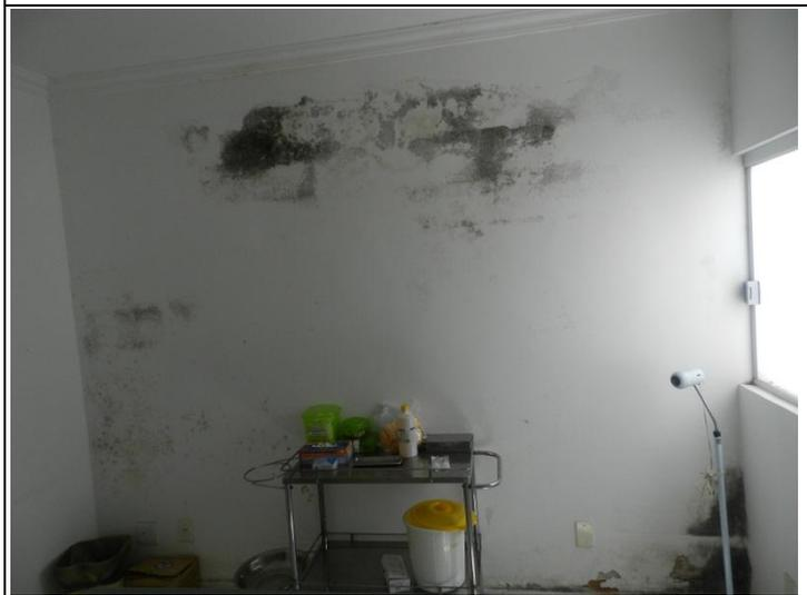
Foto 03 - Marcas de infiltrações na parede da sala de curativos – Posto de Saúde Camaçari.
