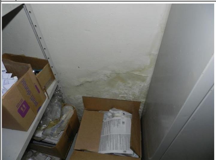
Foto 21 – Parede da farmácia com infiltrações – USF Coquelândia.
