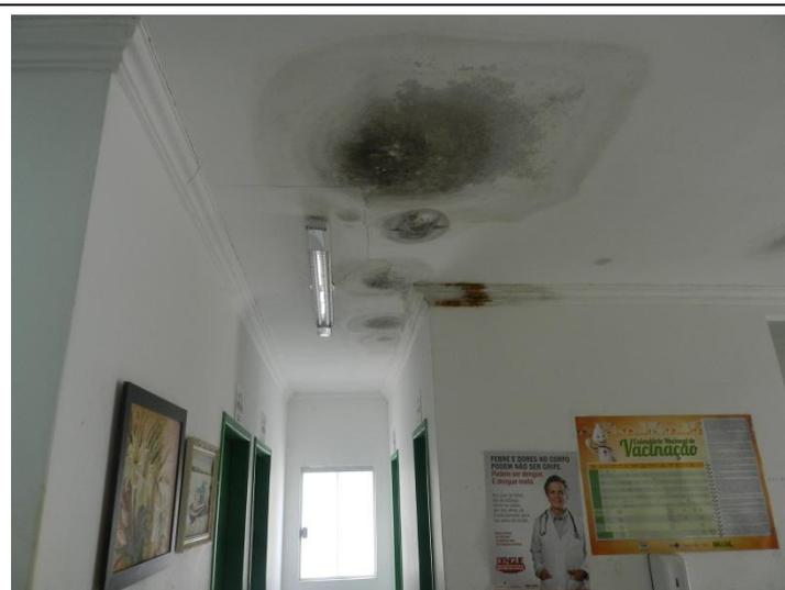
Foto 02 - Marcas de infiltrações no teto – Posto de Saúde Camaçari.
