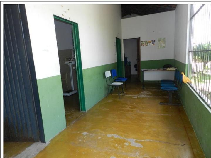
Foto 07- Inexistência de revestimento cerâmico no piso e de forro no teto – Posto de Saúde Vila Conceição.
