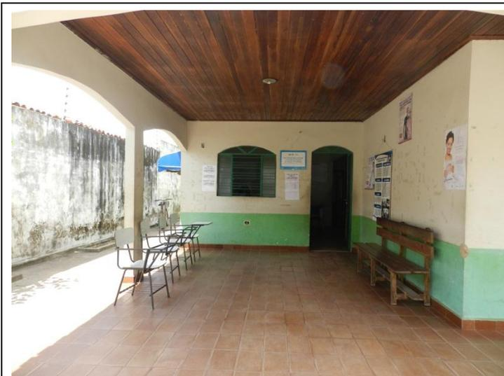
Foto 43 – Pintura das paredes deteriorada – USF Parque Anhanguera e São Salvador.
