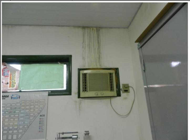
Foto 41 – Marcas de infiltrações e pintura deteriorada em paredes do consultório de equipe SF– C.S. Dr. Milton Lopes.
