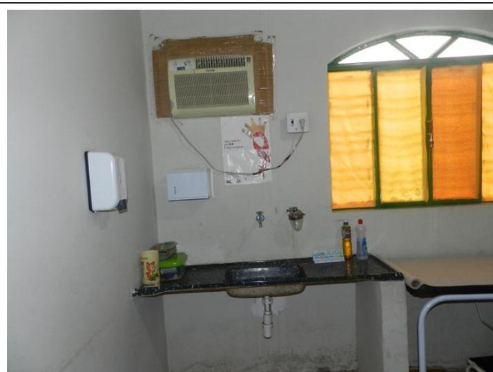
Foto 48 – Equipamento de ar – condicionado sem moldura na sala de vacina - USF Parque Anhanguera e São Salvador.
