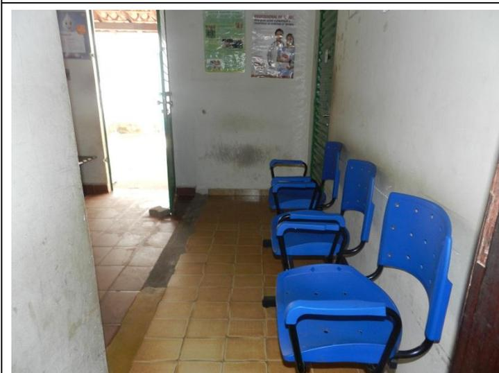
Foto 47 – Revestimento cerâmico do piso desgastado e quebrado - USF Parque Anhanguera e São Salvador.
