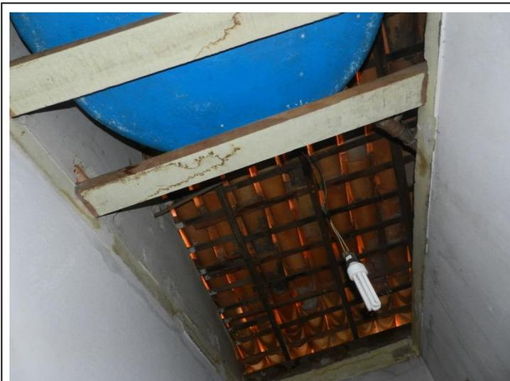
Foto 55 – Reservatório de água, sob suporte inadequado, inexistindo forro – USF Bom Sucesso.
