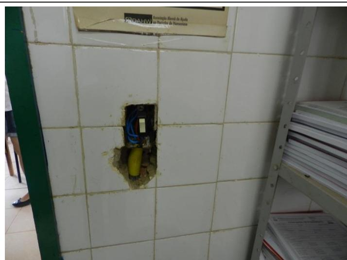
Foto 14 – Interruptor sem tampa de proteção na sala de procedimentos/arquivo – USF Coquelândia.
