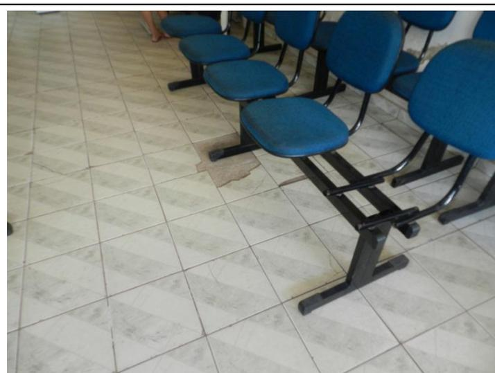
Foto 68 – Revestimento cerâmico do piso desgastado quebradiço – USF Caema.
