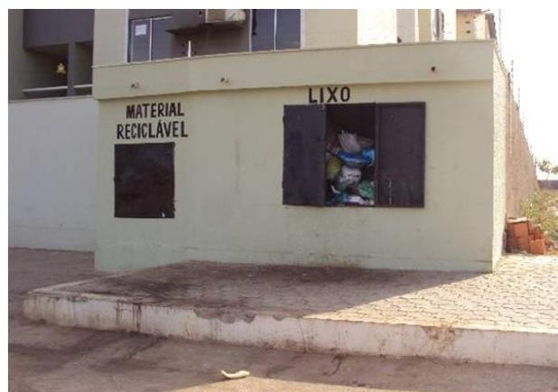
Foto: condomínio após adequação da caixa de armazenamento temporário para o material reciclável separado do lixo comum.
