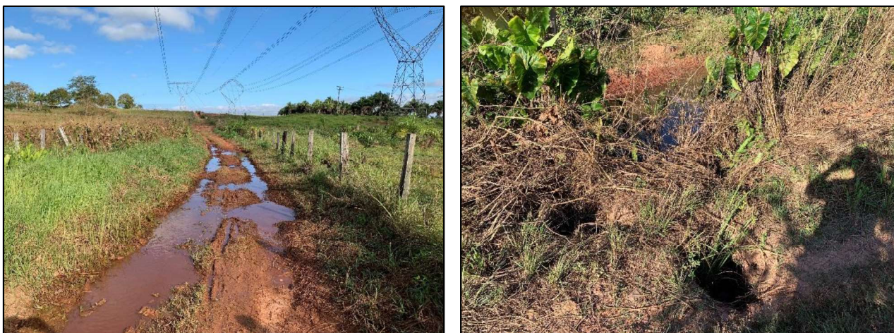
Figura 4 – Pontos de cruzamento de riachos no Acesso Principal.
