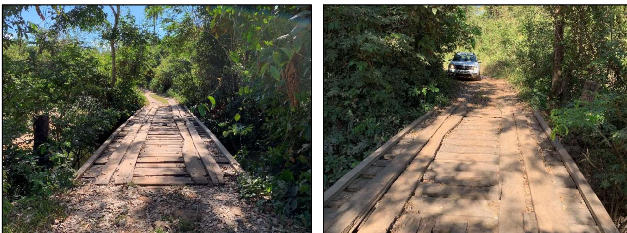
Figura 5 – Ponte sobre o rio Barra Grande – Acesso Alternativo 02.
