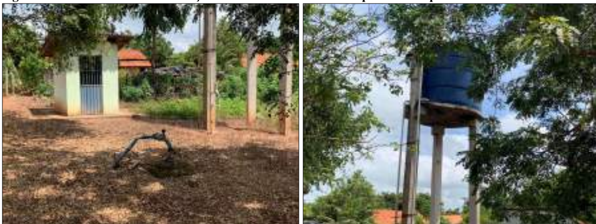
Figura 62 – SAA Nova Bacaba. Poço e Reservatório – Atendido pelo Município
