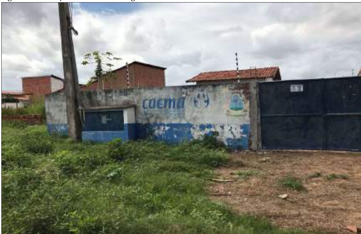
Figura 97 – Estação Elevatória de Esgoto 13.
