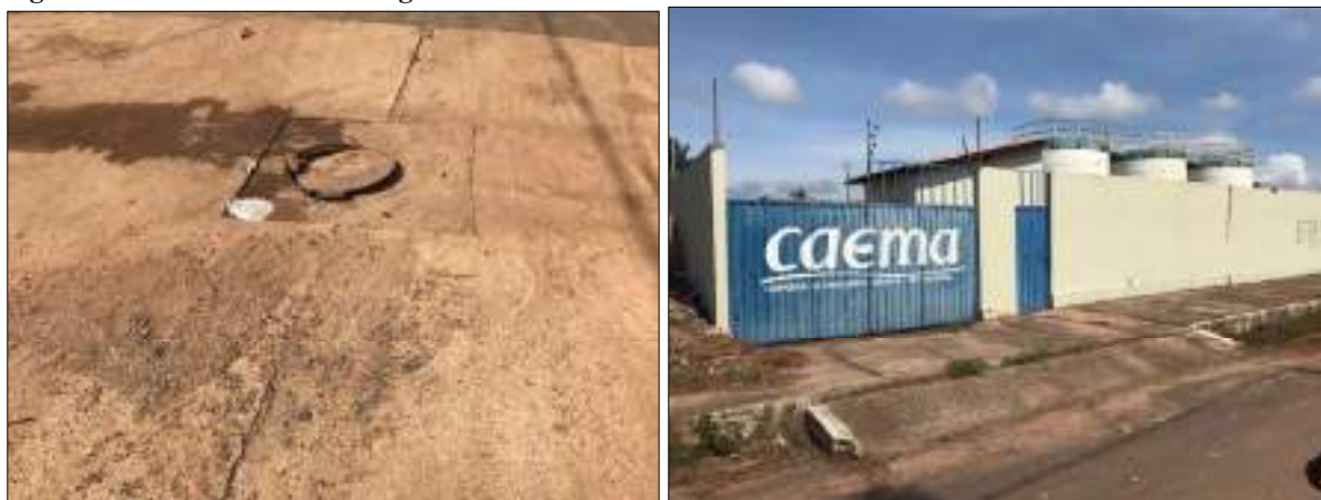
Figura 103 – ETE Sebastião Régis.
