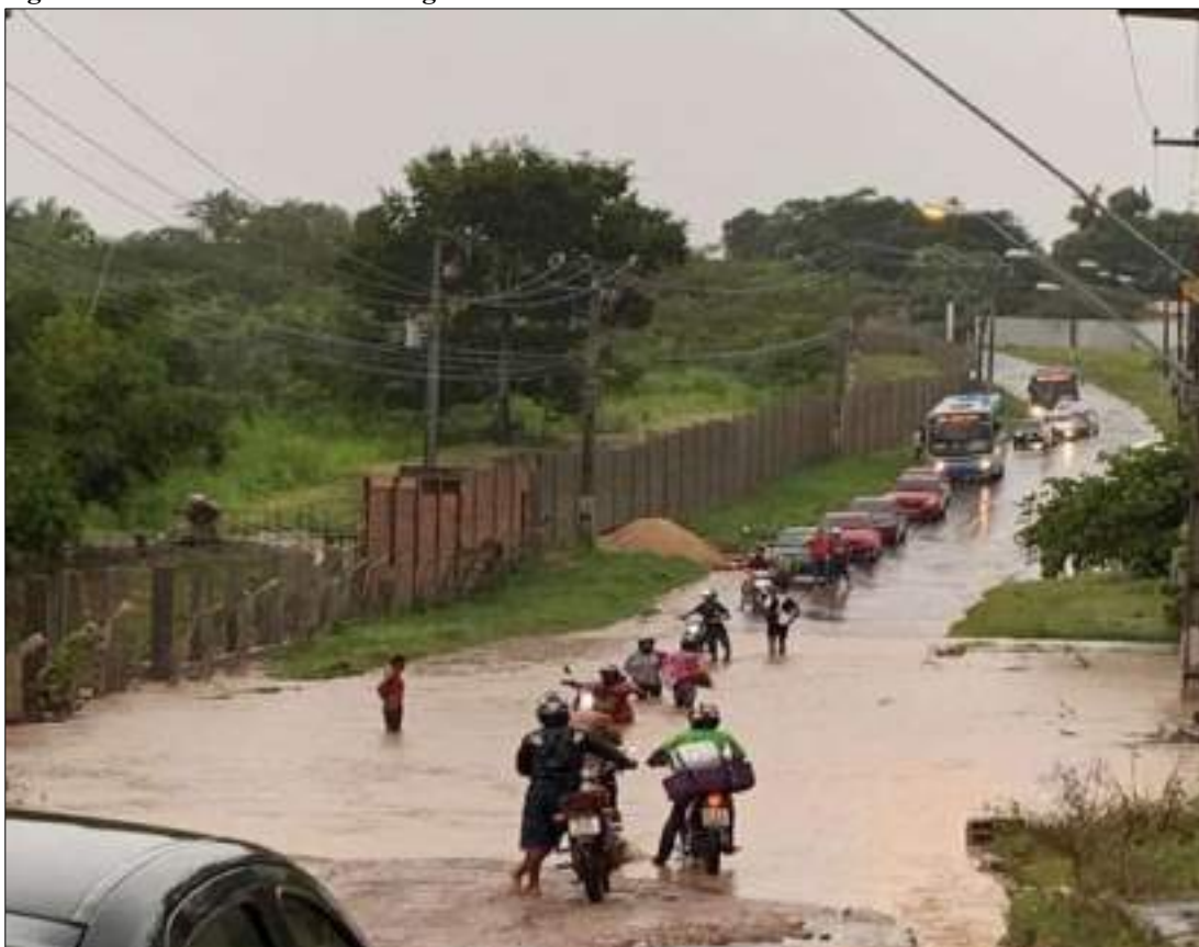
Figura 120 – Problemas de Drenagem acesso a UFMA do Bom Jesus.
