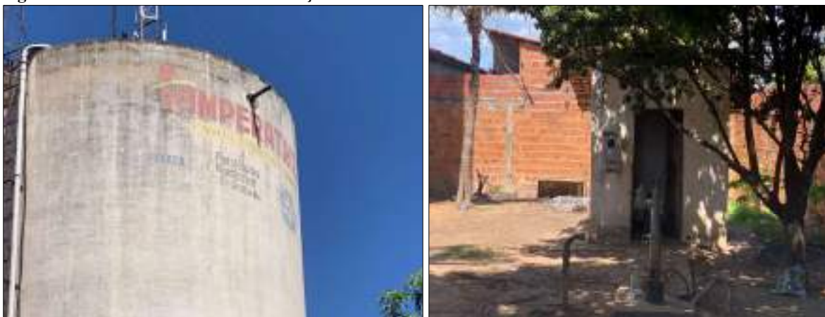
Figura 32 – RAT 10 – Vila Vitória. Poço e Reservatório.
