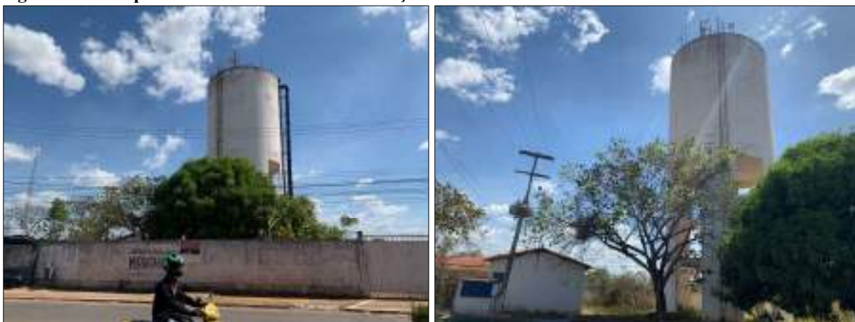
Figura 25 – Parque Senharol – Reservatório e Poço Profundo- REL 11.
