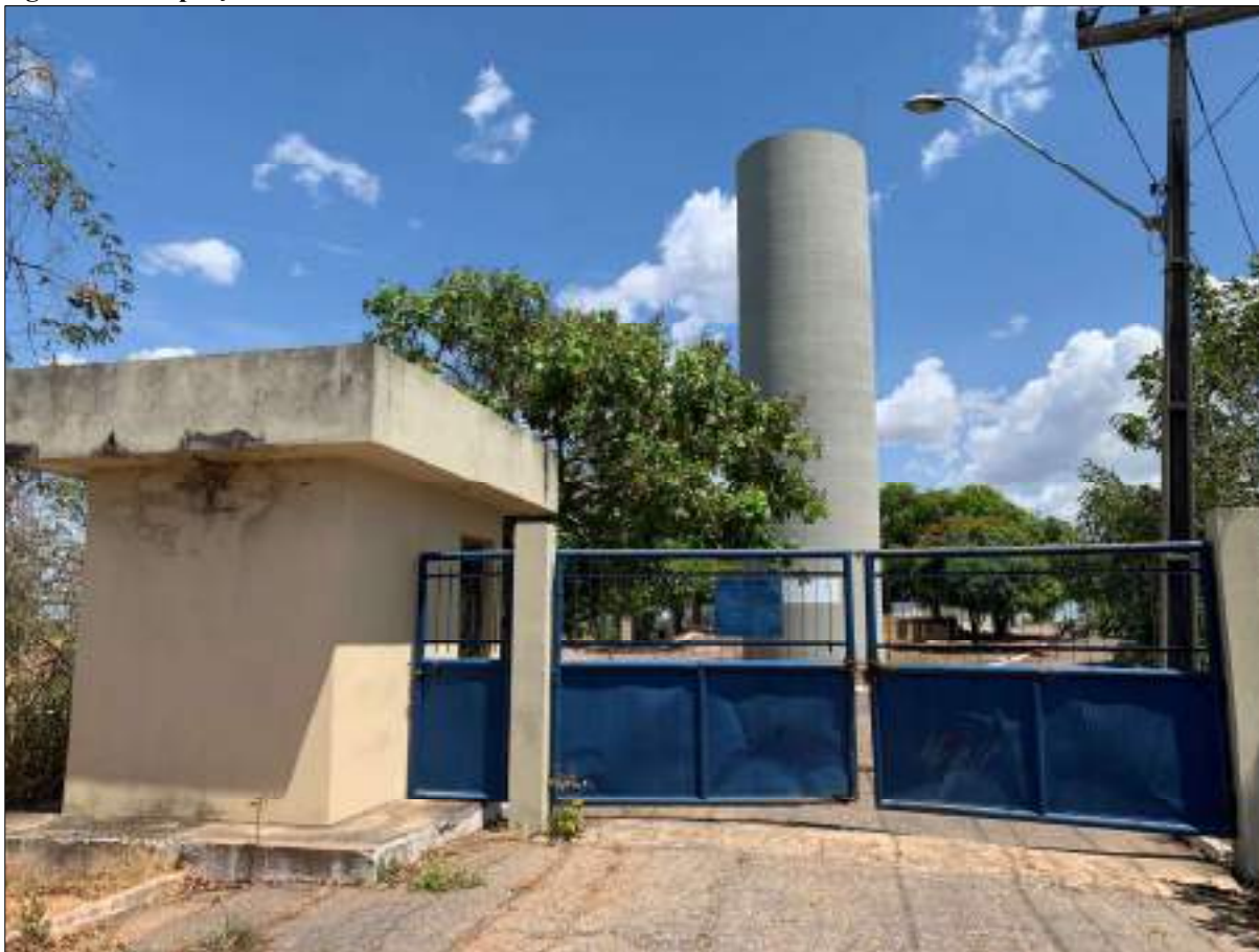
Figura 16 – Captação Rio Tocantins.
