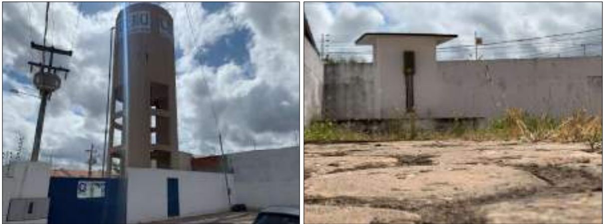
Figura 41 – RAT 20 – Condomínio ECOPARK. Poço e Reservatório.
