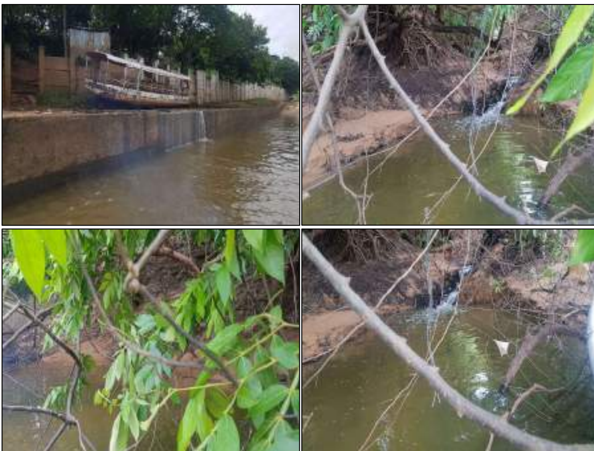
Figura 106 – Lançamento de Esgoto – Rio Tocantins. Cais do Porto e Emissário das Lagoas no Rio Tocantins – Coordenadas -55.08102 -47.516039.
