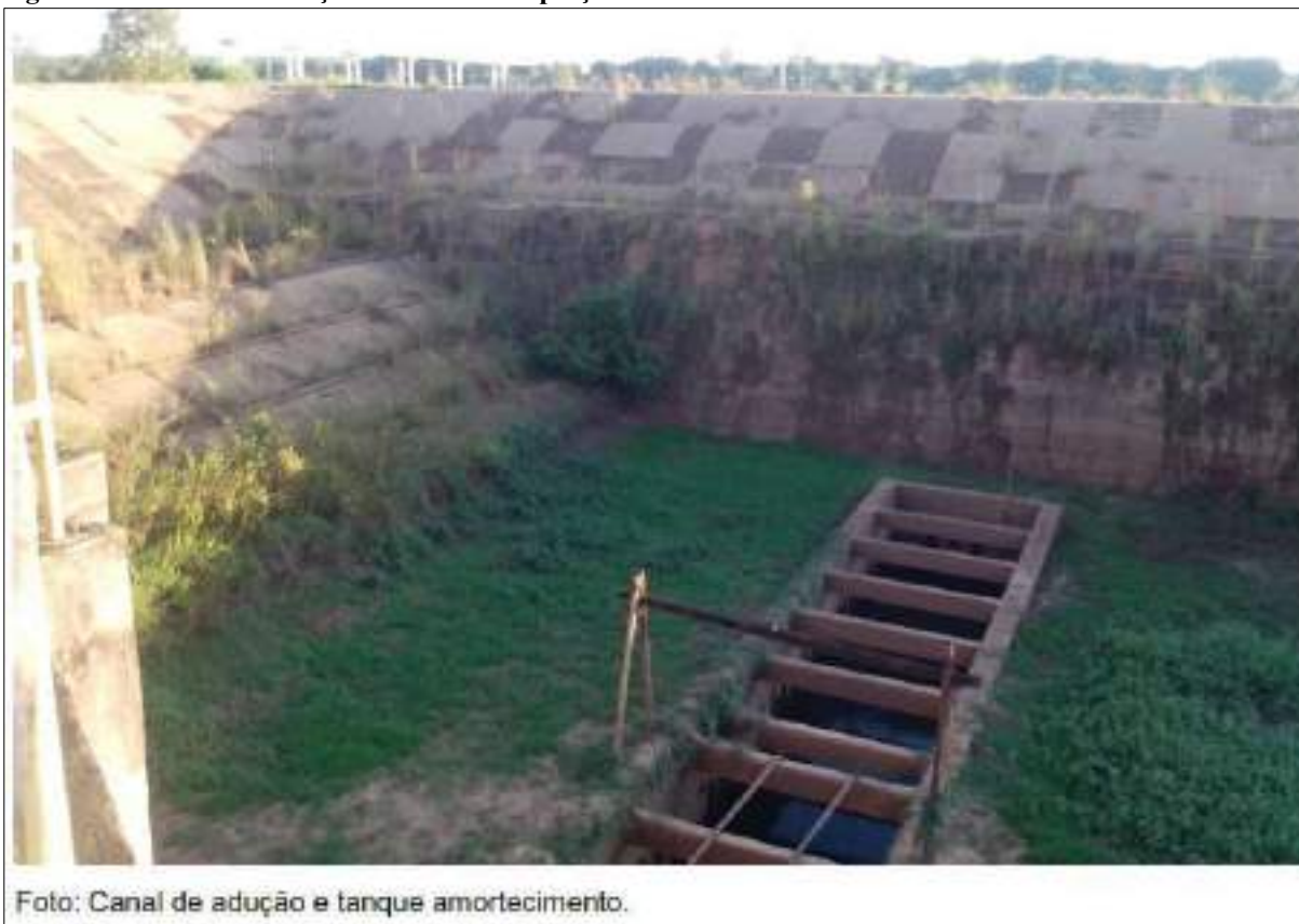
Figura 17 – Canal de Adução CAEMA – Captação Rio Tocantins.
