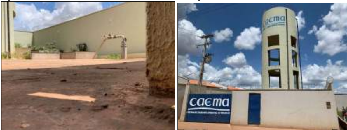
Figura 44 – RAT 23 – Bairro Bom Jesus – Residencial Village. Poço e Reservatório
