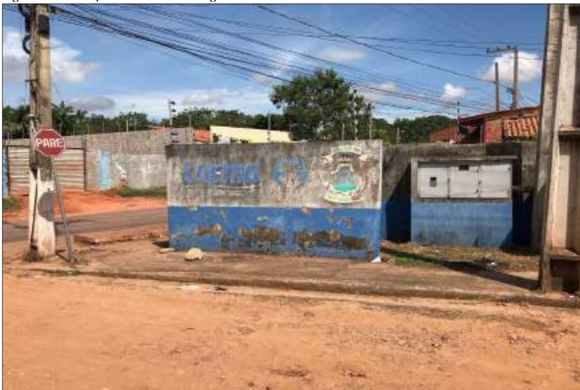
Figura 96 – Estação Elevatória de Esgoto 12.
