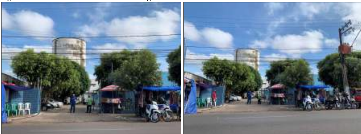
Figura 34 – RAT 13 - Avenida Getúlio Vargas – Sede da CAEMA. REL 01 – Reservatório.
