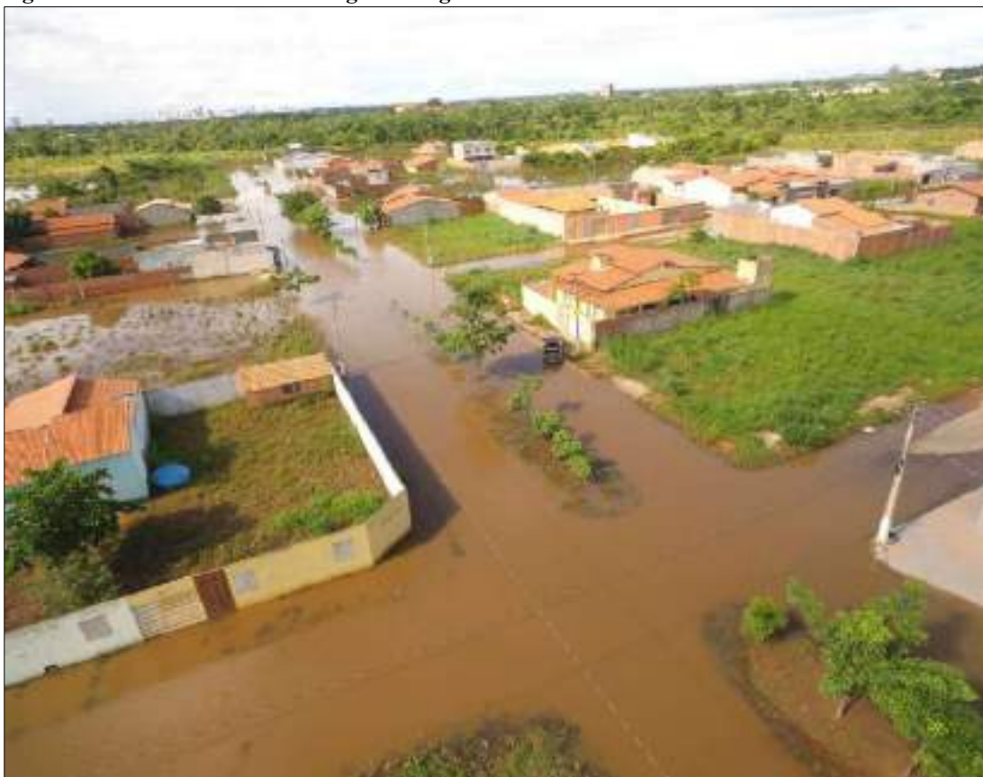
Figura 122 – Problemas de Drenagem- Alagamentos oriundos das chuvas.
