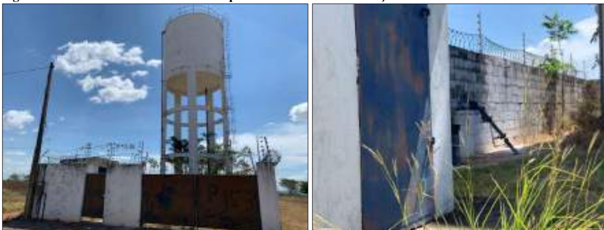
Figura 31 – RAT 09 – Loteamento Parque das Flores. REL 08 Poço e Reservatório.
