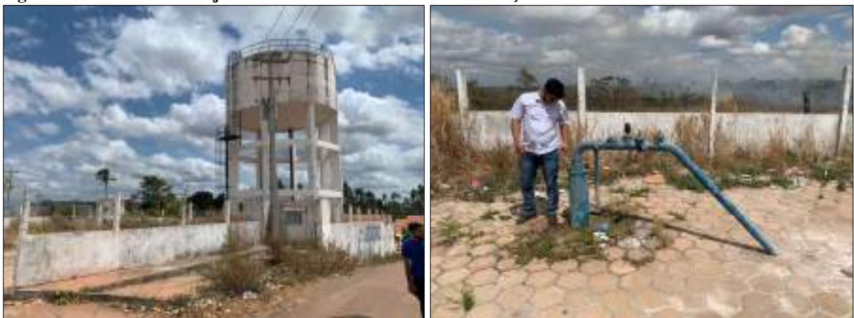
Figura 43 – RAT 22 – Conjunto Residencial Teotônio Vilela. Poço e Reservatório.
