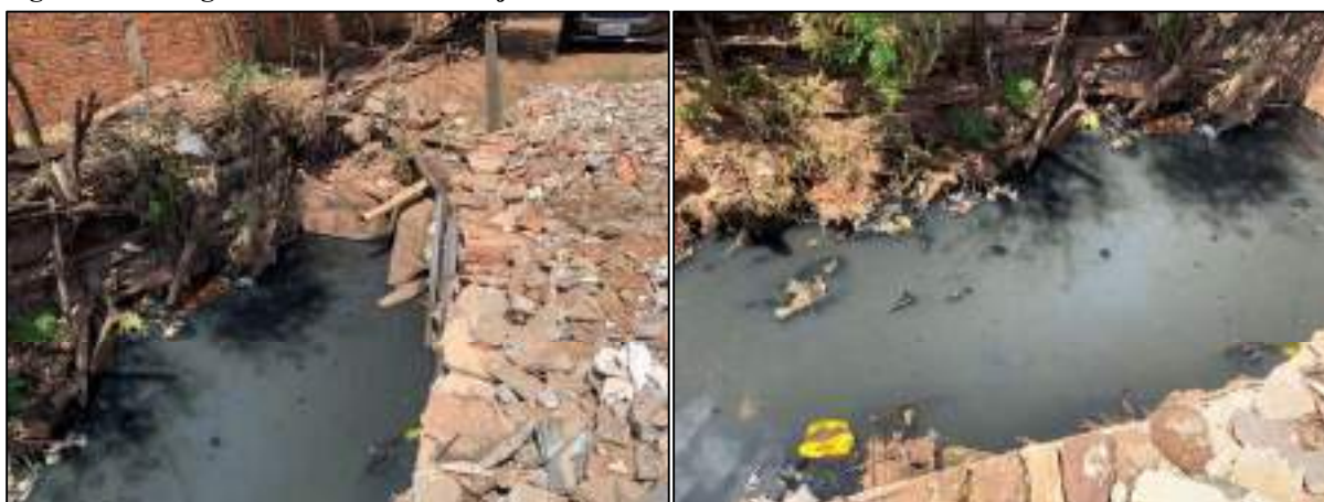
Figura 108 – Esgoto a céu aberto – Conjunto Nova Vitória.
