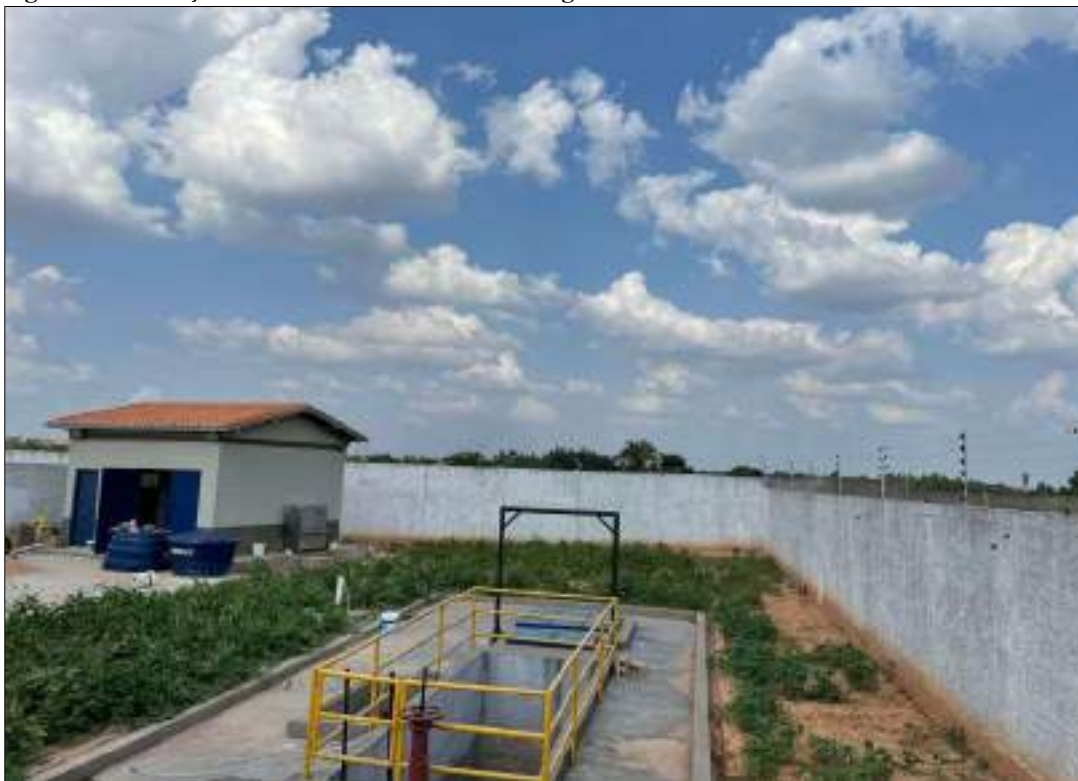
Figura 99 – Estação Elevatória Condomínio Village II.
