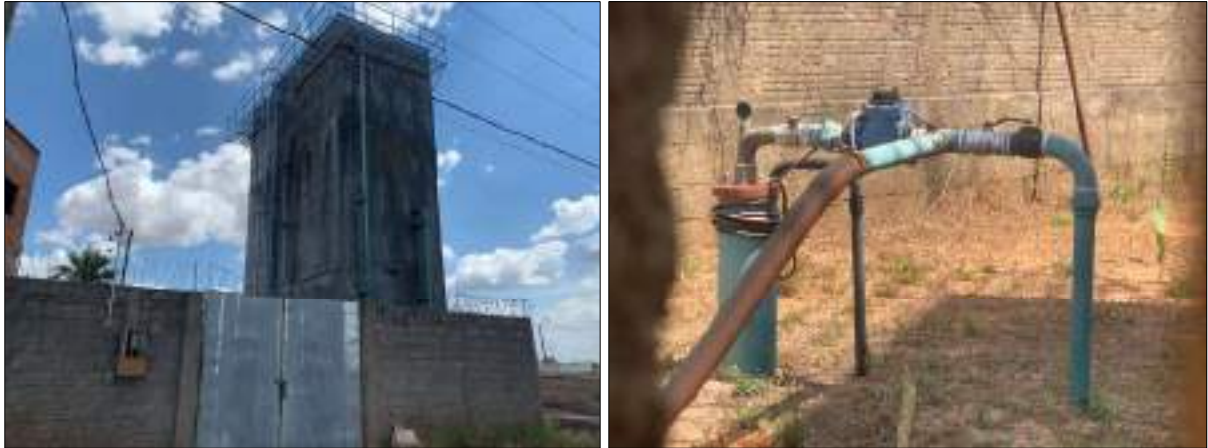
Figura 47 – RAT 26 – Império Romano. Poço e Reservatório.
