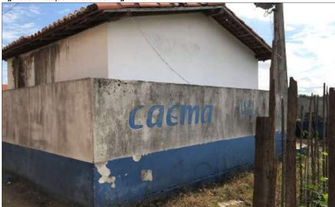
Figura 95 – Estação Elevatória de Esgoto 11.
