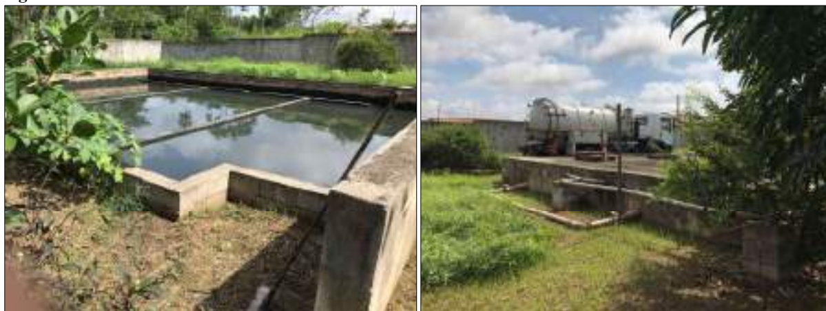
Figura 101 – ETE ITAMAR GUARÁ.
