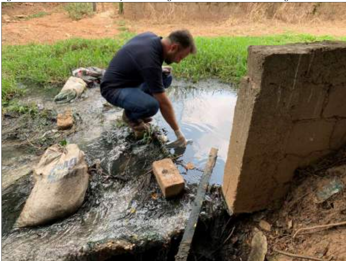
Figura 84 – Ponto 08 - Ponto de Lançamento do Esgotamento Sanitário – Sebastião Régis.
