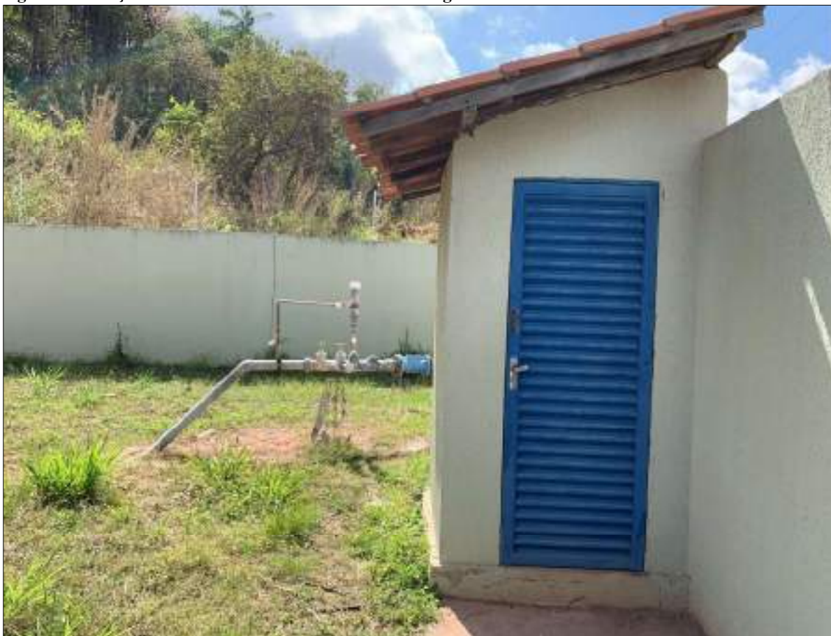
Figura 24 – Poço e Reservatório RAT 03 – Sebastião Régis.
