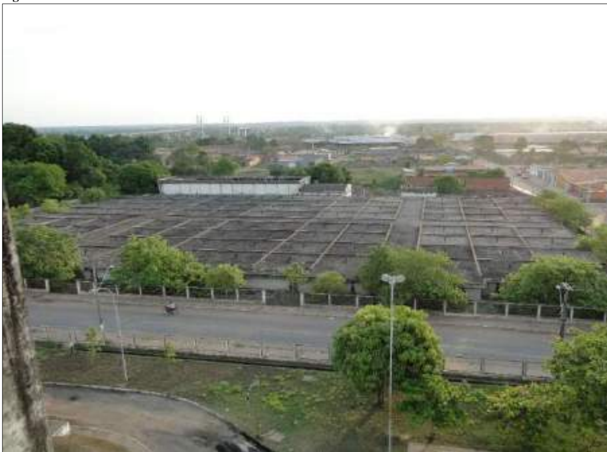
Figura 20 – Reservatório ETA – R7.
