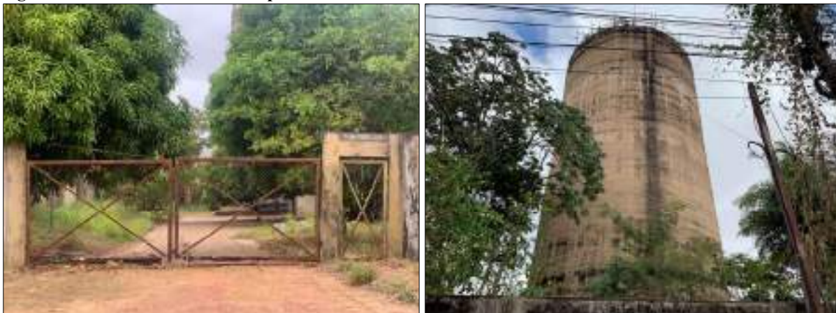
Figura 38 – RAT 17 - Jardim Tropical – nº 09 e 10. RAP 09 e REL 010 – Reservatórios.
