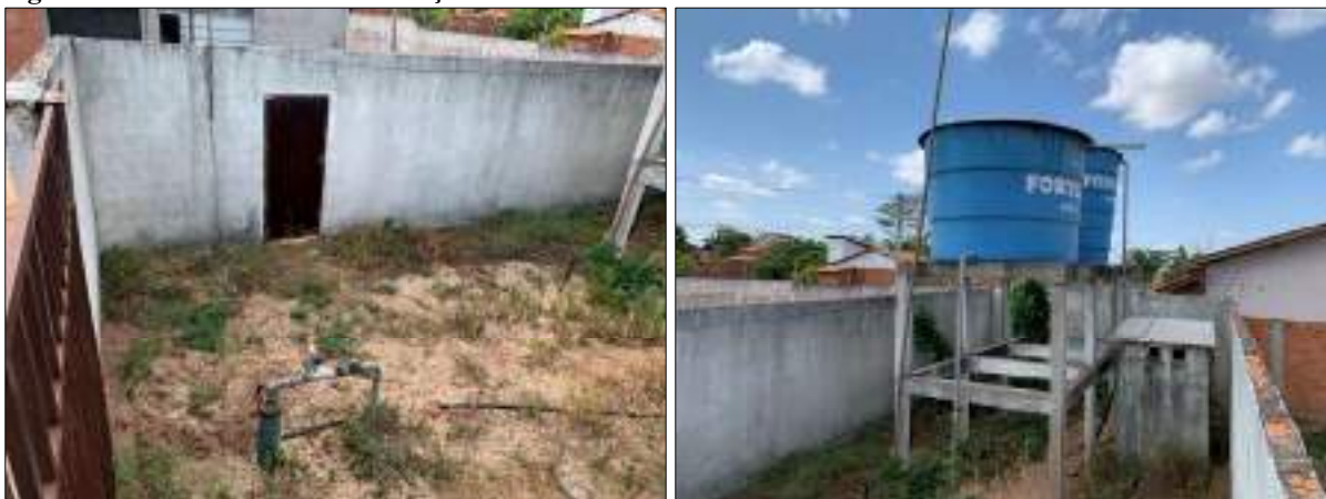
Figura 23 – RAT 02 – Sumaré- Poço e reservatório.
