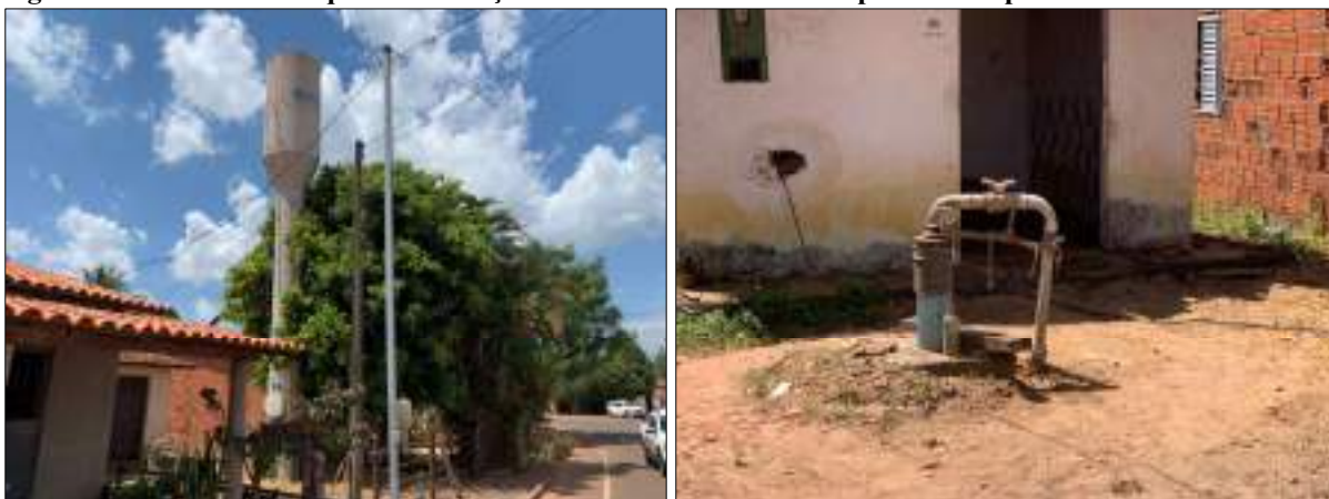
Figura 56 – RAT 35 – Coquelândia. Poço e Reservatório – atendido pelo município.
