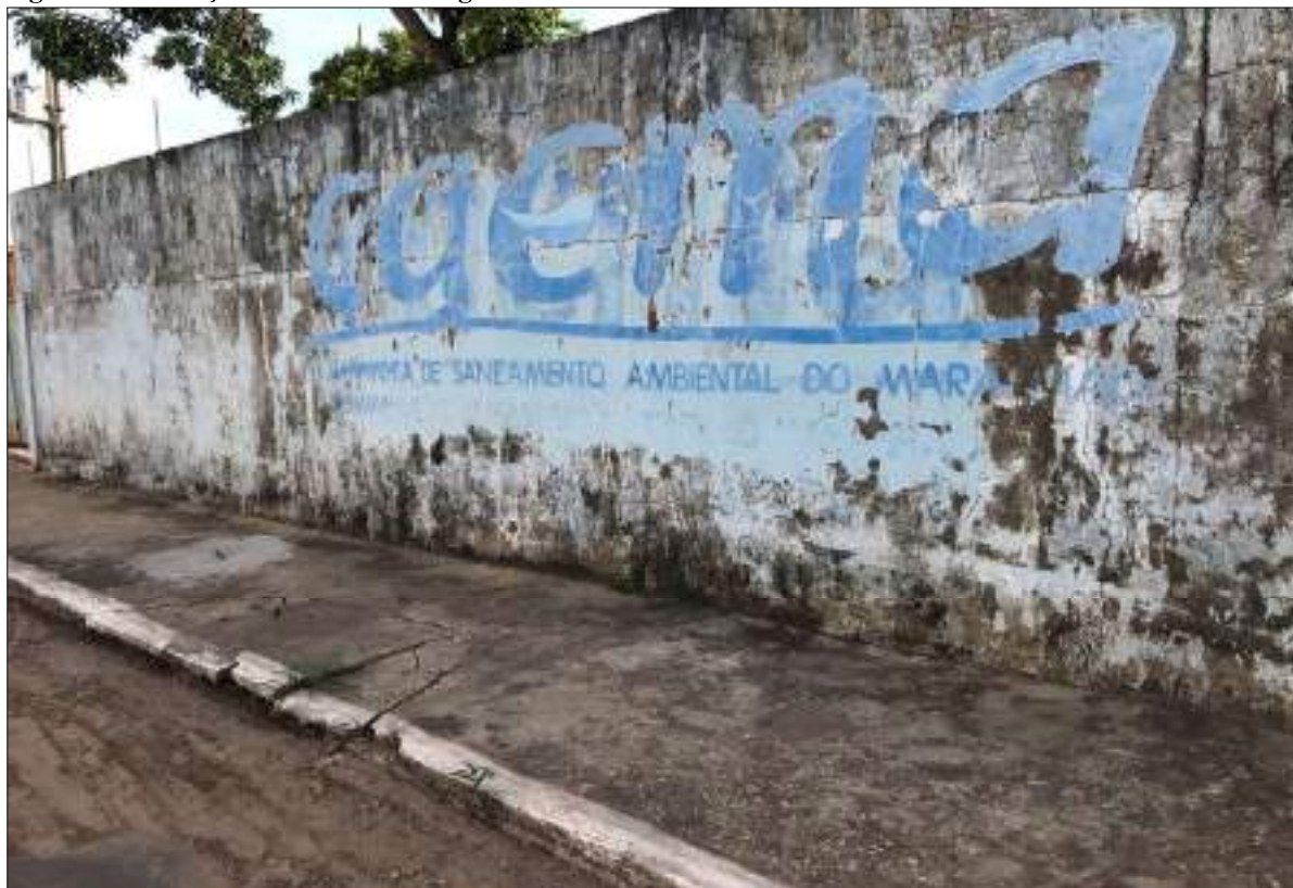
Figura 92 – Estação Elevatória de Esgoto 07.
