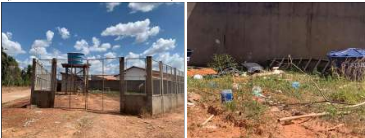
Figura 51 – RAT 30 – Jardim das Oliveiras I. Poço e Reservatório.
