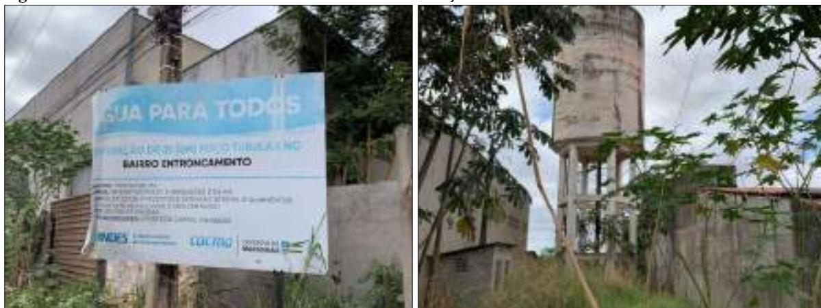
Figura 37 – RAT 16 – Bairro Entroncamento. REL 06 Poço e Reservatório.
